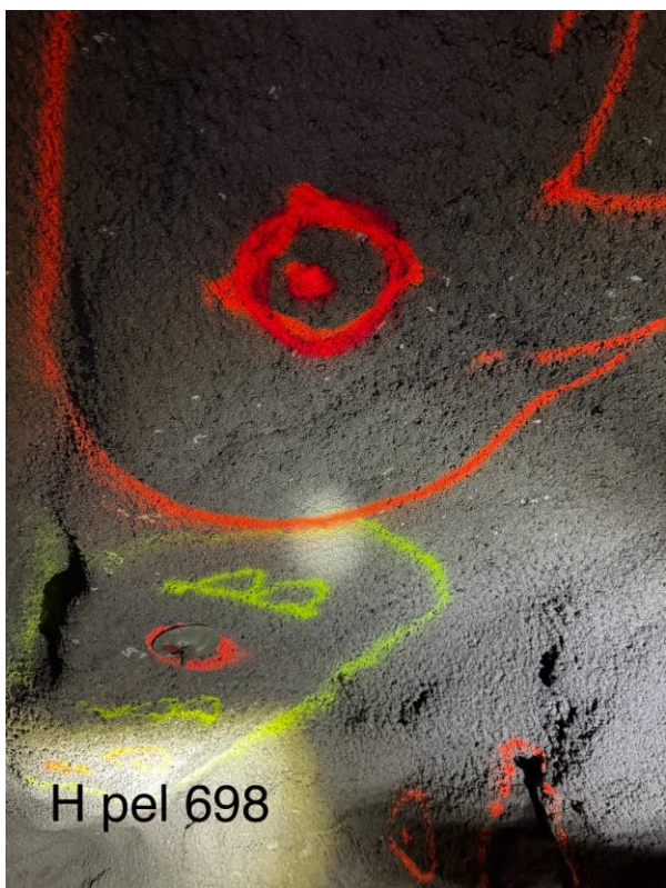
Foto 16. Pel 698 h. side, bom i sprøytebetong. Området anbefales å sikres med 1 stk. 2,4 meter bolt.
