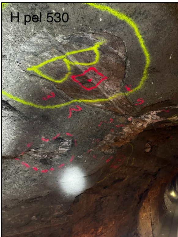
Foto 14. Pel 530 h. side, bom i bart berg. Området anbefales å sikres med 1 stk. 2,4 meter bolt.
