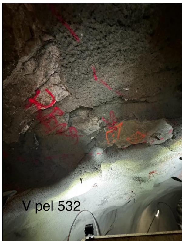
Foto 15. Pel 532 v. side, avskalling/løs sprøytebetong. Området anbefales å renskes og sikres med sprøytebetong.
