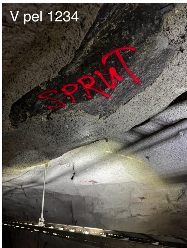
Foto 21. Pel 1234 v. side, manglende sprøytebetong. Området anbefales å sikres med sprøytebetong.
