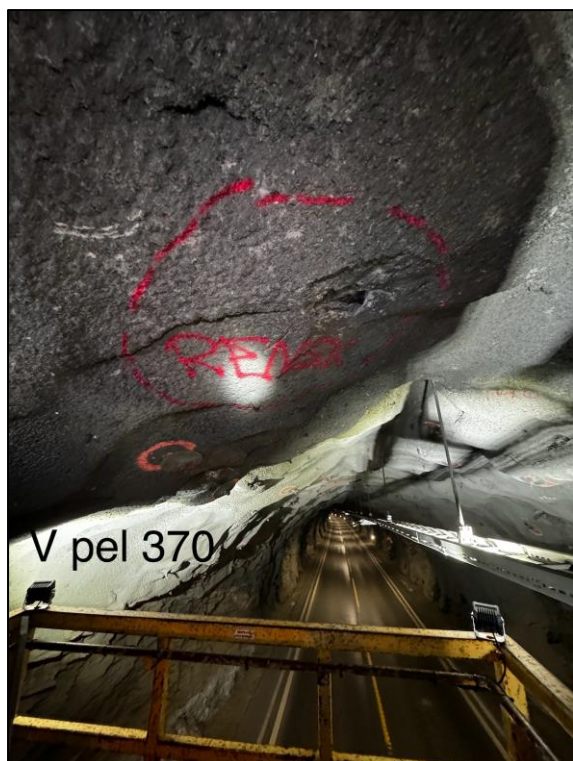
Foto 7. Pel 370, noe løs sprøytebetong. Området anbefales å renskes og påføre ny sprøytebetong.
