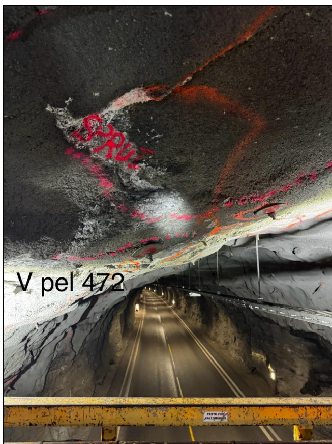
Foto 12. Pel 472, manglende sprøytebetong/avskalling. Området anbefales å sikres med sprøytebetong.
