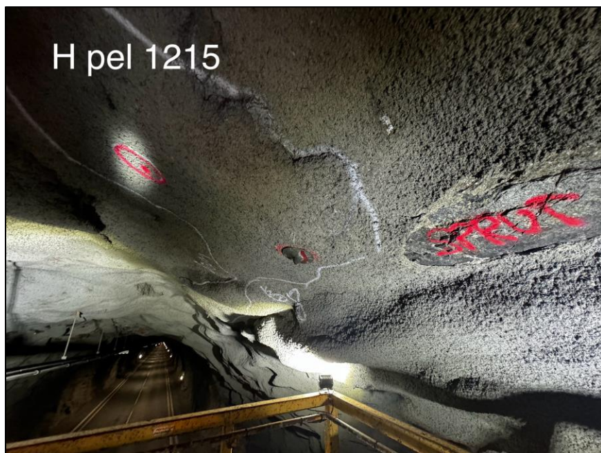
Foto 19. Pel 1215 h. side, bom og manglende sprøytebetong. Området anbefales å sikres med 1 stk. 2,4 meter bolt og sprøytebetong.
