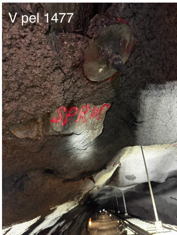
Foto 23. Pel 1477 v. side, manglende sprøytebetong. Området anbefales å sikres med sprøytebetong.
