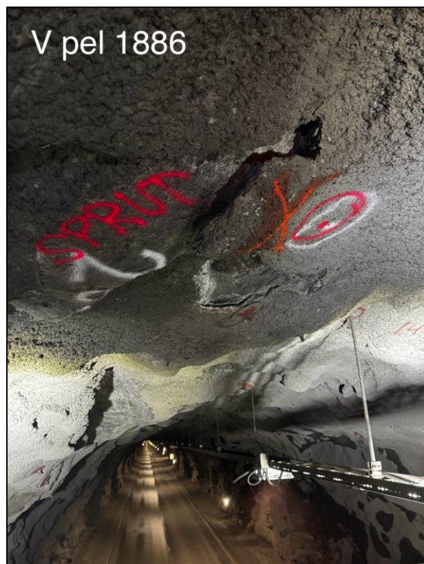
Foto 24. Pel 1886, v. side, tidligere merket for bolt, løs sprøytebetong. Området anbefales å sikres med 1 stk. 2,4 meter bolt og sprøytebetong.
