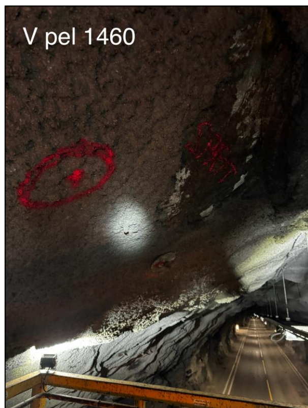
Foto 22. Pel 1460 v. side, bom og manglende sprøytebetong. Området anbefales å sikres med 1 stk. 2,4 m bolt og sprøytebetong.
