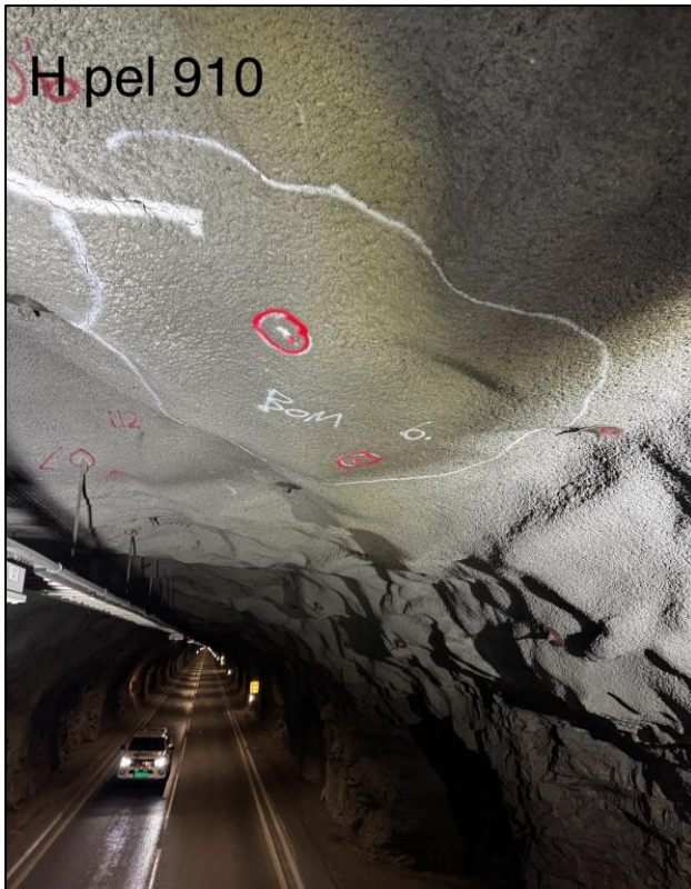
Foto 17. Pel 910 h. side, bom i sprøytebetong. Området anbefales å sikres med 2 stk. 2,4 m bolt.
