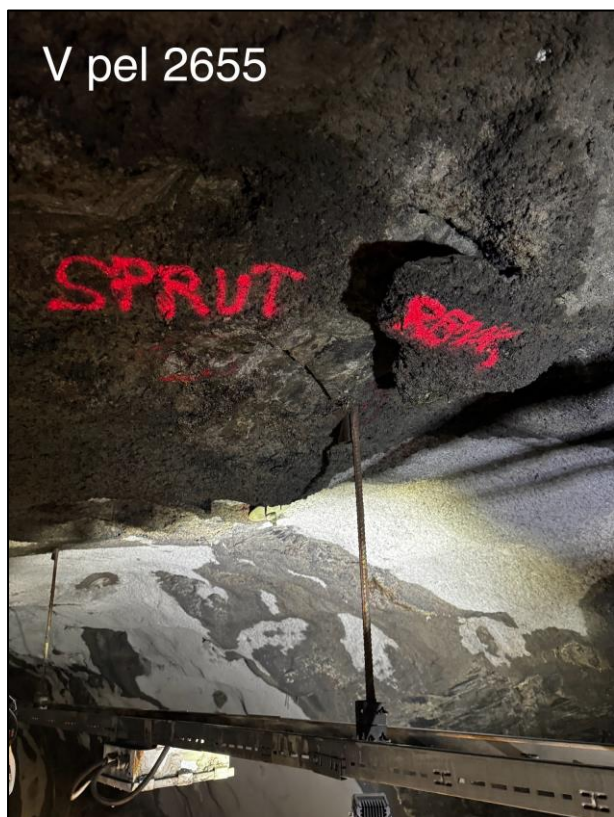
Foto 28. Pel 2655 v. side, blokk henger delvis i sprøytebetong. Området anbefales å renskes og sikres med sprøytebetong. Dersom det ikke er mulig å renske, må det settes 1 stk. 2,4 meter bolt.
