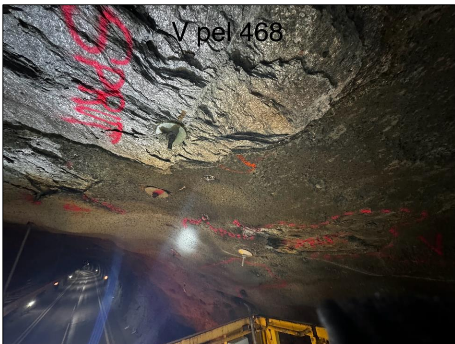
Foto 11. Pel 468, manglende sprøytebetong/avskalling. Området anbefales å sikres med sprøytebetong.
