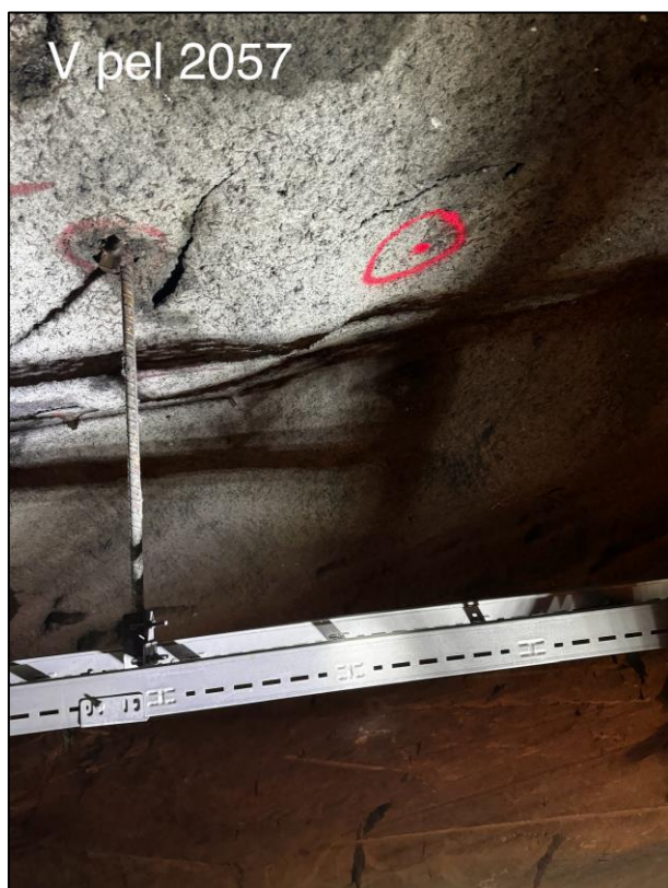
Foto 26. Pel 2057, bom og tynn sprøytebetong. Området anbefales å renskes, evt supplere med bolt etter rensk, i tillegg til sikring med sprøytebetong.
