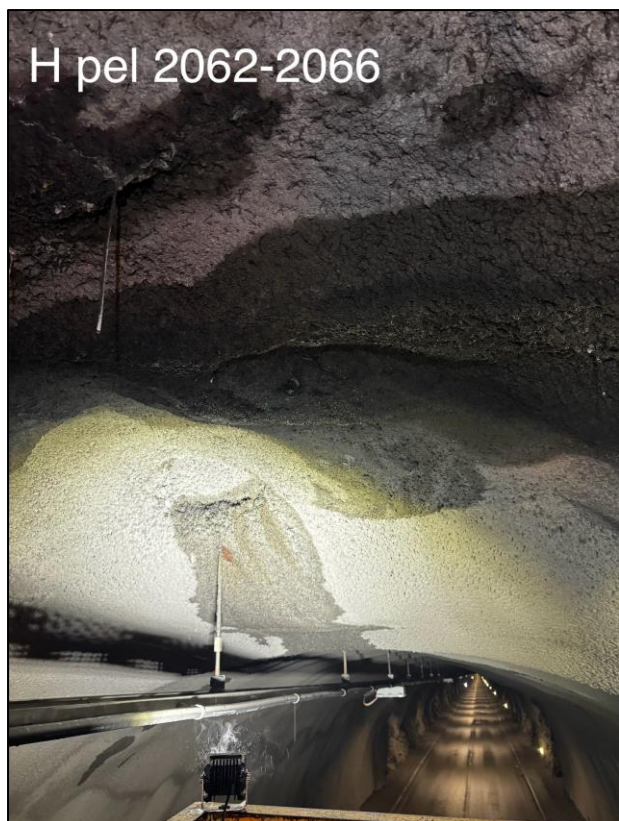
Foto 27. Pel 2062-2066 h. side, drypp fra vederlag/heng. Området anbefales å sikres med brannsikret PE-skum.
