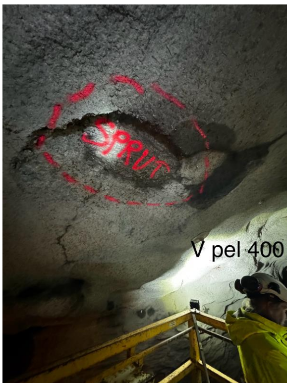
Foto 8. Pel 400, avskalling av sprøytebetong og bom. Området anbefales å sikres med 1 stk. 2,4 meter bolt og sprøytebetong.
