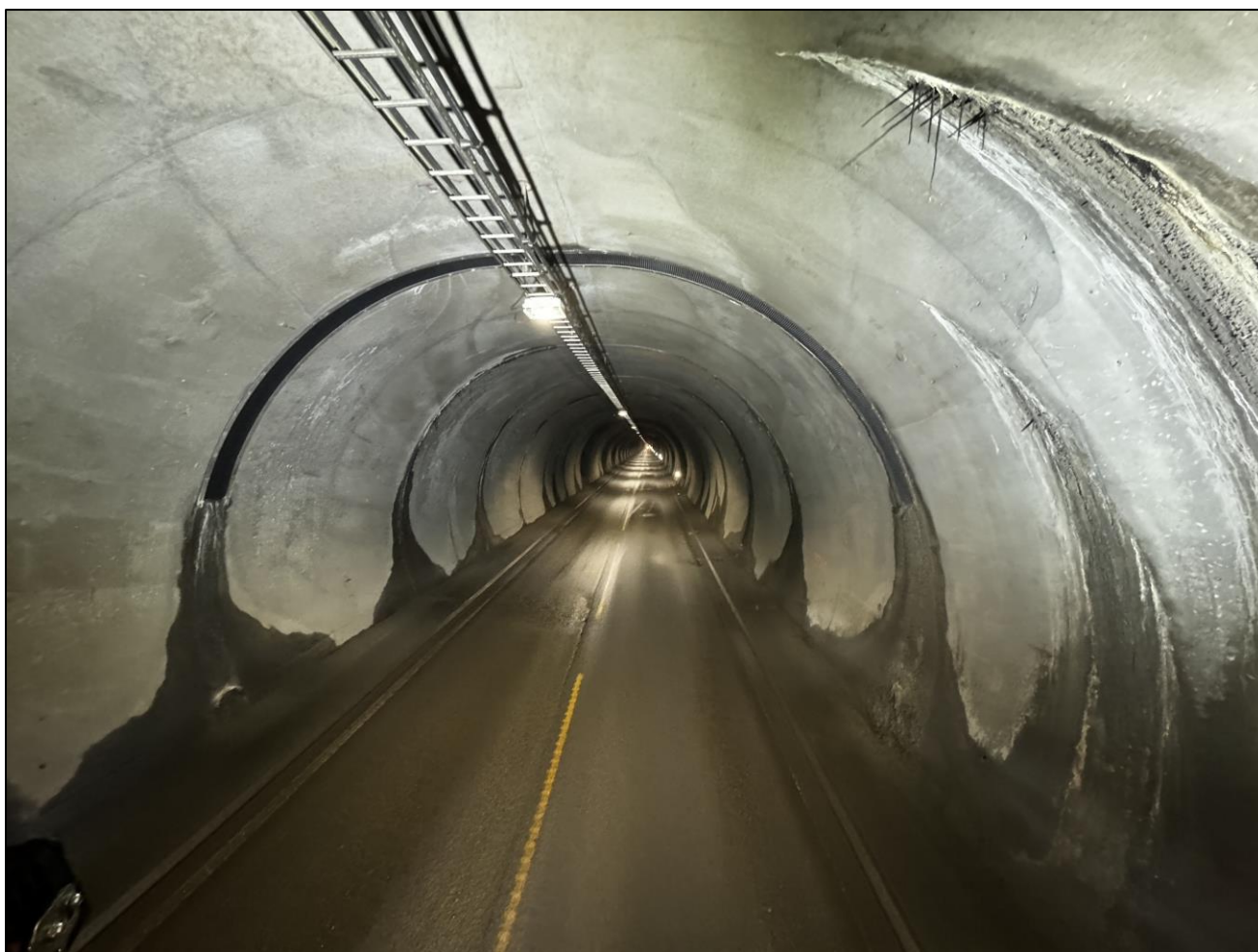
Foto 29. Generelt foto av utstøpning i tunnel. Det er observert områder med fukt i skjøtene.
