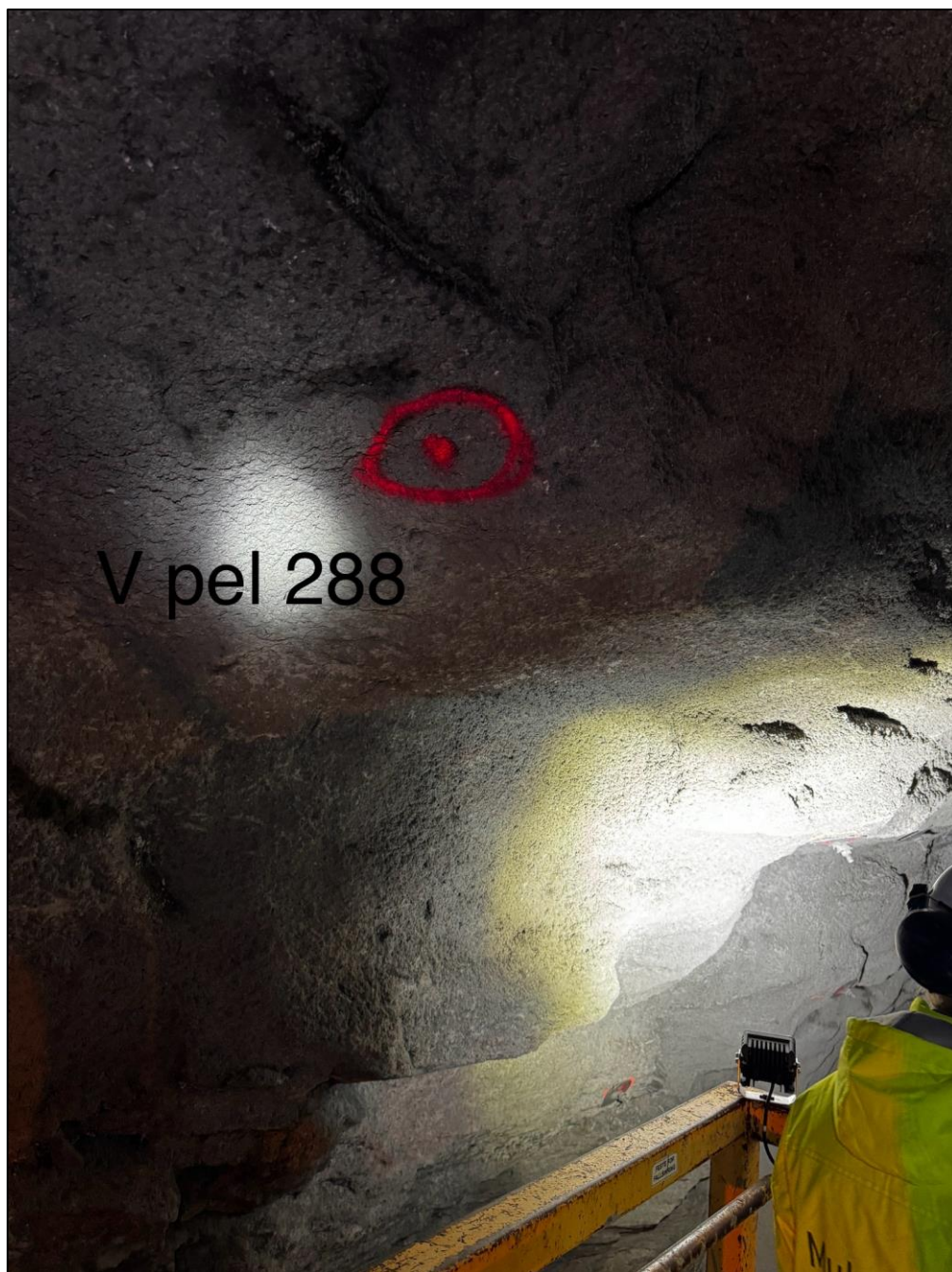
Foto 4. Pel 288 v. side: bom i sprøytebetong. Sikres med 1 stk. 2,4 m bolt.
